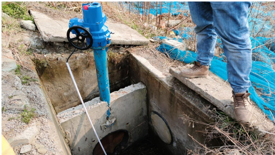
(4) 雨水排放口手自一体切断阀
